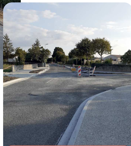
Carrefour rue de Beauregard rue de Gratte Chat
